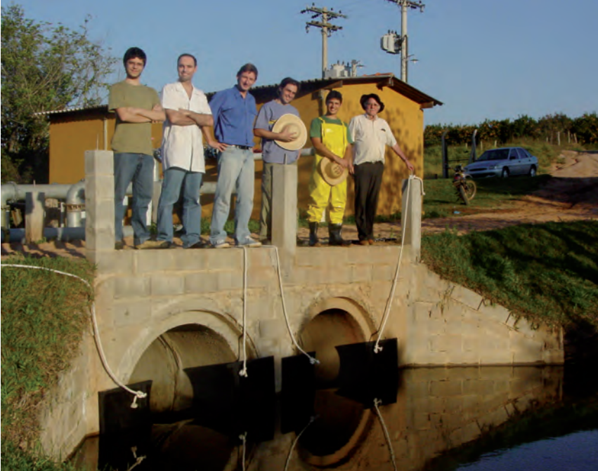
Instalação de uma represa circular móvel para a medição da descarga de um riacho em uma bacia hidrográfica localizada na zona de afloramento do aquífero Guarani.
