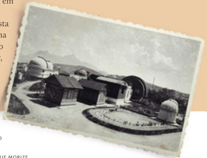
Pavilhões e cúpulas destinados aos instrumentos astronômicos do Observatório Nacional, 1921
