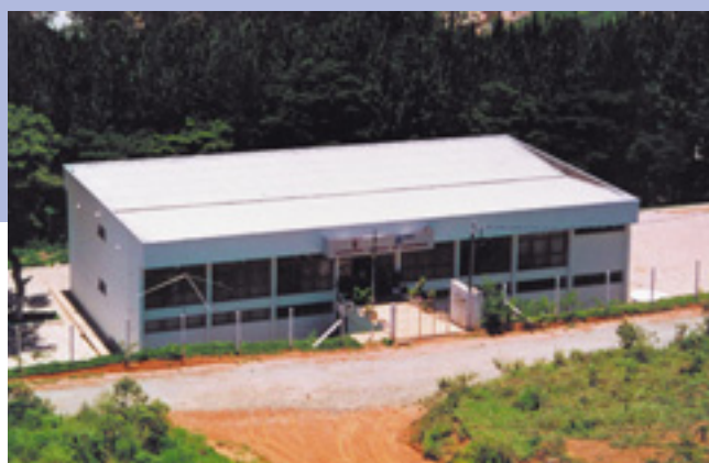
Vista da sede administrativa do LNA no ano de sua inauguração, 1993
