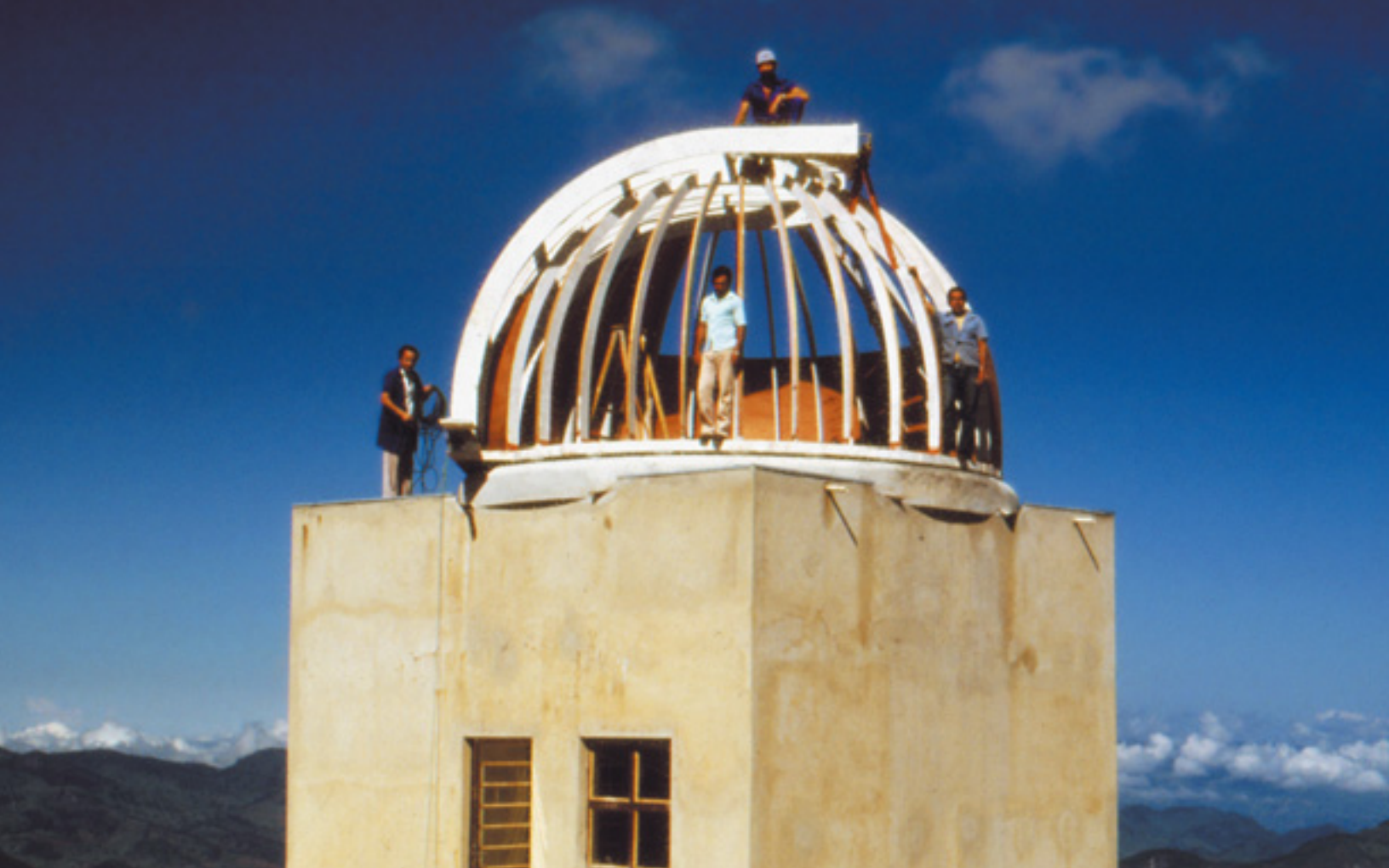
Montagem da cúpula do telescópio Zeiss de 0,60m, 1982
