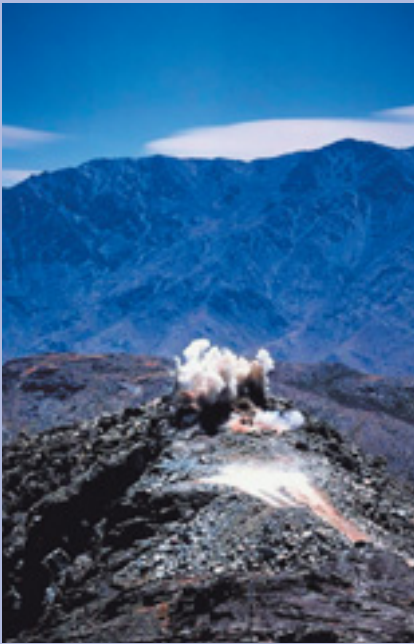
Trabalhos de terraplanagem no sítio destinado ao SOAR, em Cerro Pachón, 1998 FONTE: SOAR CONSORTIUM INC.
