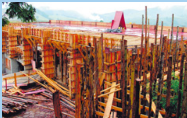
Prédio destinado aos laboratórios do LNA durante sua construção, em foto de 2004
