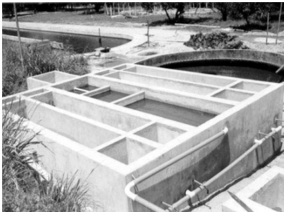
Figura 7.4 Filtro anaeróbio (UFRN)
