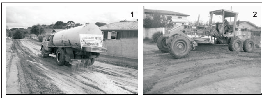
Figura 4.12 Ensaio de reúso da água em Campo Largo - PR (maio 2006). (1) Aplicação em compactação de estrada; (2) Atividades complementares da compactação.
