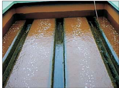
Final da aplicação de ar
