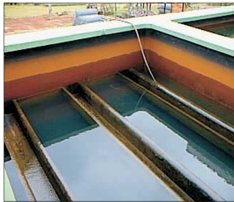
Final da lavagem com água
