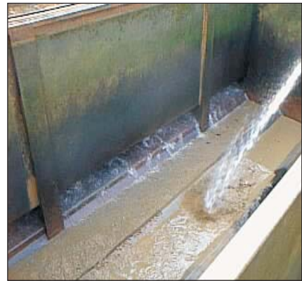
Limpeza manual de decantador convencional de escoamento horizontal com introdução de água proveniente de mangueira
