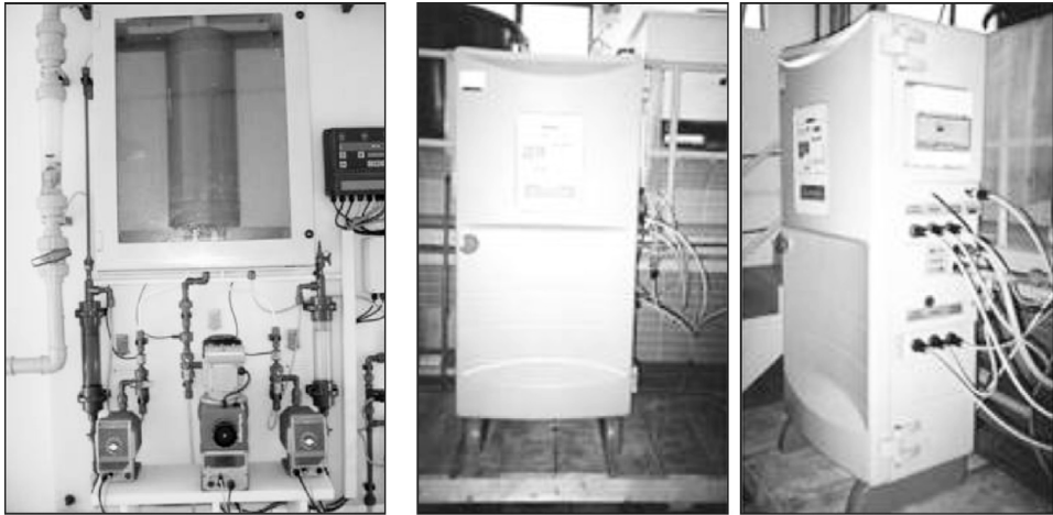
a) Gerador de dióxido de cloro em escala real – ETE Cambuí (PUCPR).
