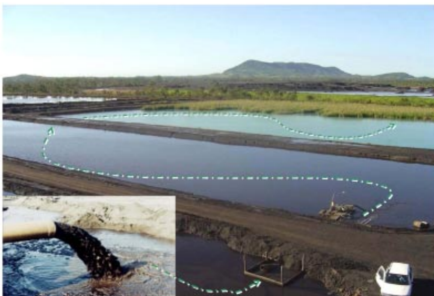
Figura 6 – Seqüência da decantação do efluente de beneficiamento (no detalhe).
