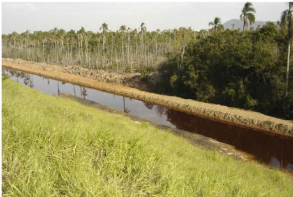
Figura 4 – Canal de contenção responsável pela drenagem das águas de lixívia de rejeitos, integrado ao sistema de drenagem e tratamento de DAM (janeiro/2000), na mesma perspectiva da figura 3
