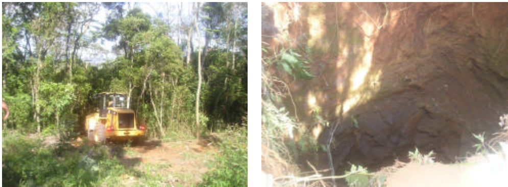
Figura 6 - Trabalhos de fechamento de poço de ventilação com argila. Bairro Naspolini, Criciúma/SC
