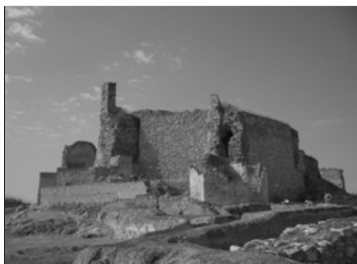
Fig.1. Vista General de Calatrava la Vieja
