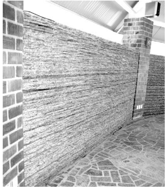
Foto 13 – Pannel interno. Obra Jaciguá. 2006 (foto do autor).
