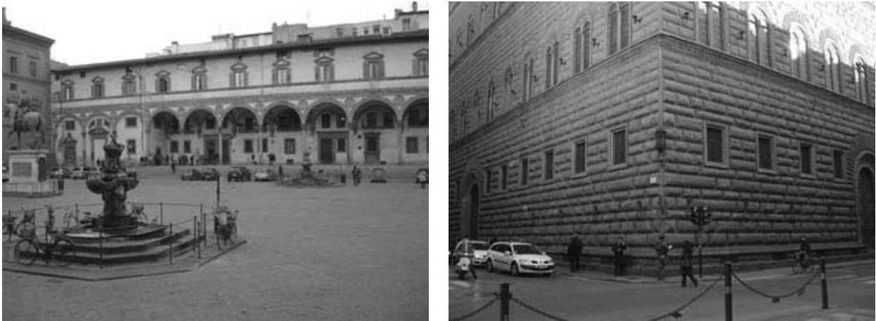
Figura 1. Exemplos da utilização do arenito “Pietra Serena” na arquitetura da Cidade de Florença. Hospital dos Santos Inocentes (esquerda); Palazzo Grozzi (direita).
