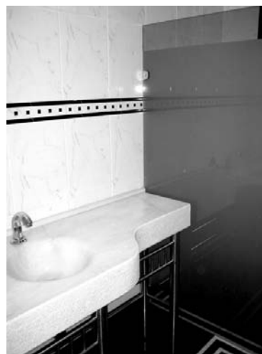
Foto 22 – Bancada maciça escavada em casqueiro de grande espessura. Obra Karmak. 2005 (foto do autor).
