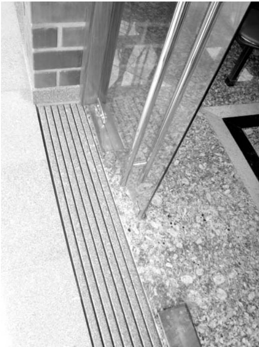
Foto 25 – Ralo na porta, em tiras. Obra Jaciguá. 2006 (f. autor)
