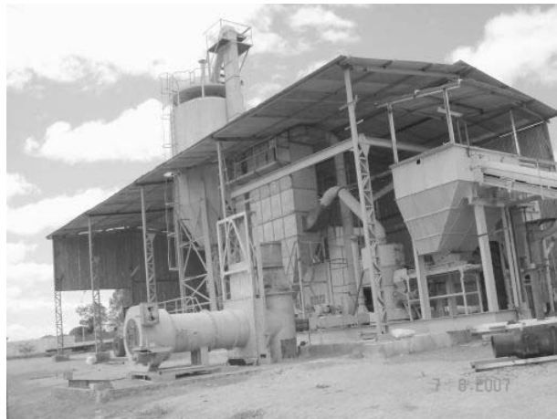
Figura 5: Vista externa da FORTECAL Ltda.
