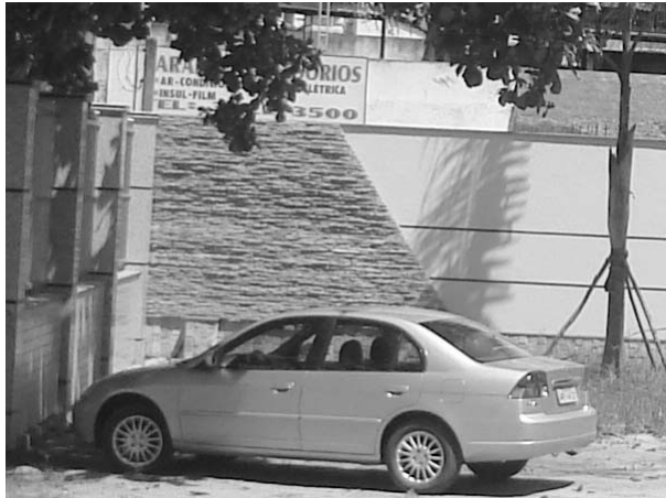
Foto 12 – Pannel externo Obra Karmak. 2005 (foto do autor).
