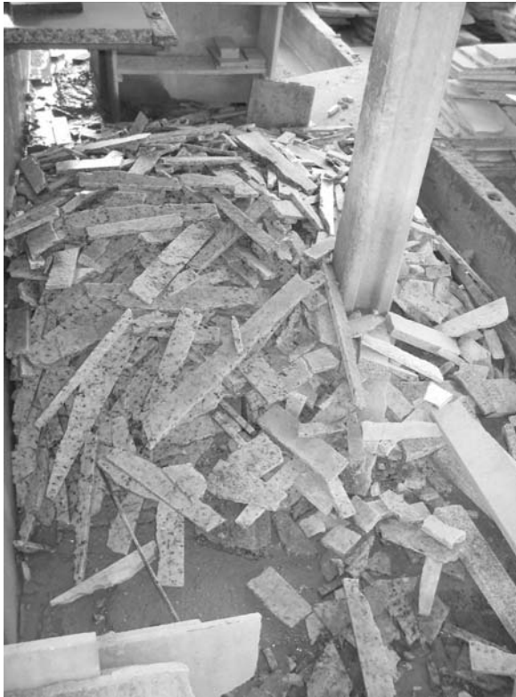
Foto 10 – Tiras quebradas do esquadrejamento (f. autor).
