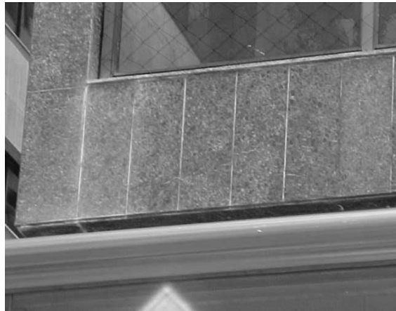
Figura 7: Granito Marrom Imperial (Eflorescência) Fonte: Silva, S.A.
