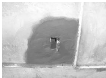
Figura 14 – Argamassa com lama Abrasiva
