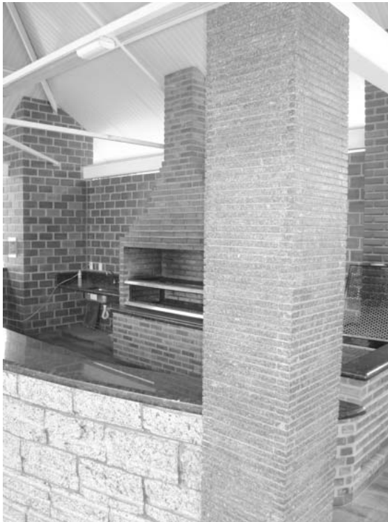
Foto 14 – Colunas em tiras, balcão em casqueiro assente com a face corrugada para o exterior. Obra Jaciguá. 2006 (foto do autor).
