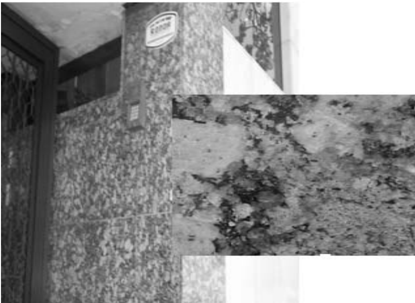
Figura 1 – Alteração na cor - Granito Amarelo Florença
