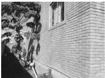
Figura 13 – Casa de tijolo solo-cimento (lama abrasiva)
