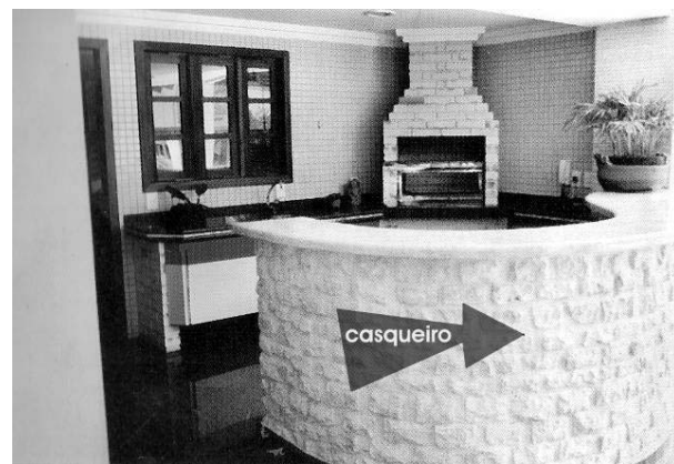
Foto 20 – Churrasqueira. Balcão com blocos de casqueiro. Obra R. Azevedo. Capa e matéria da Revista Pedras do Brasil. 2002 (foto: César Romero).
