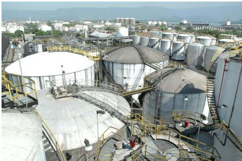
Figura 5.3-31: Terminal Santos (tanques para estocagem de granéis líquidos)
