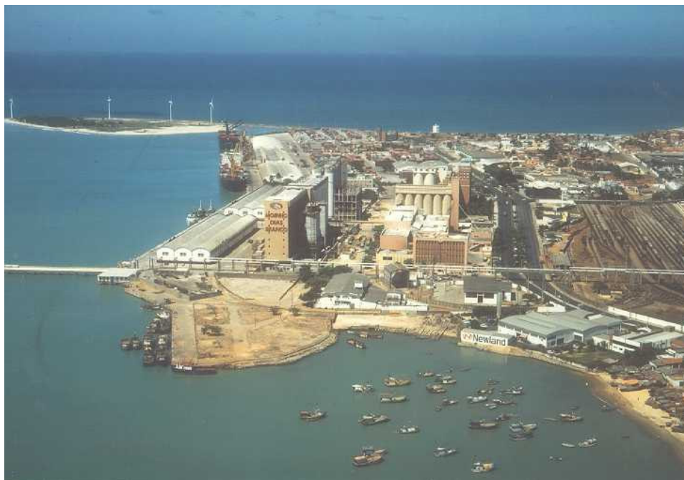
Figura 5.3-21: Porto de Fortaleza
