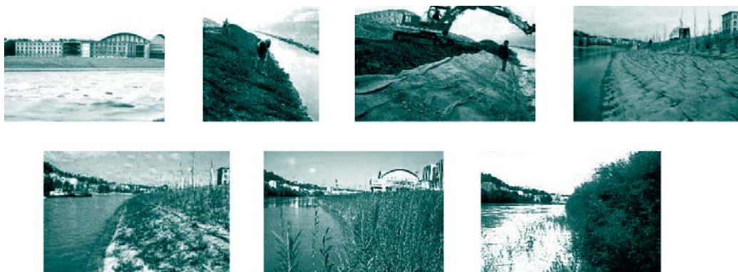
Figura 2-8: Recuperação da margem do Rio Ródano (Lyon/França)
