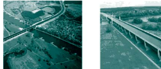
Figura 2-10: Canal/ponte sobre o Rio Elba
