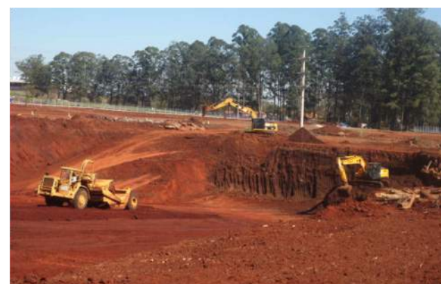
Obras de terraplanagem em execução
