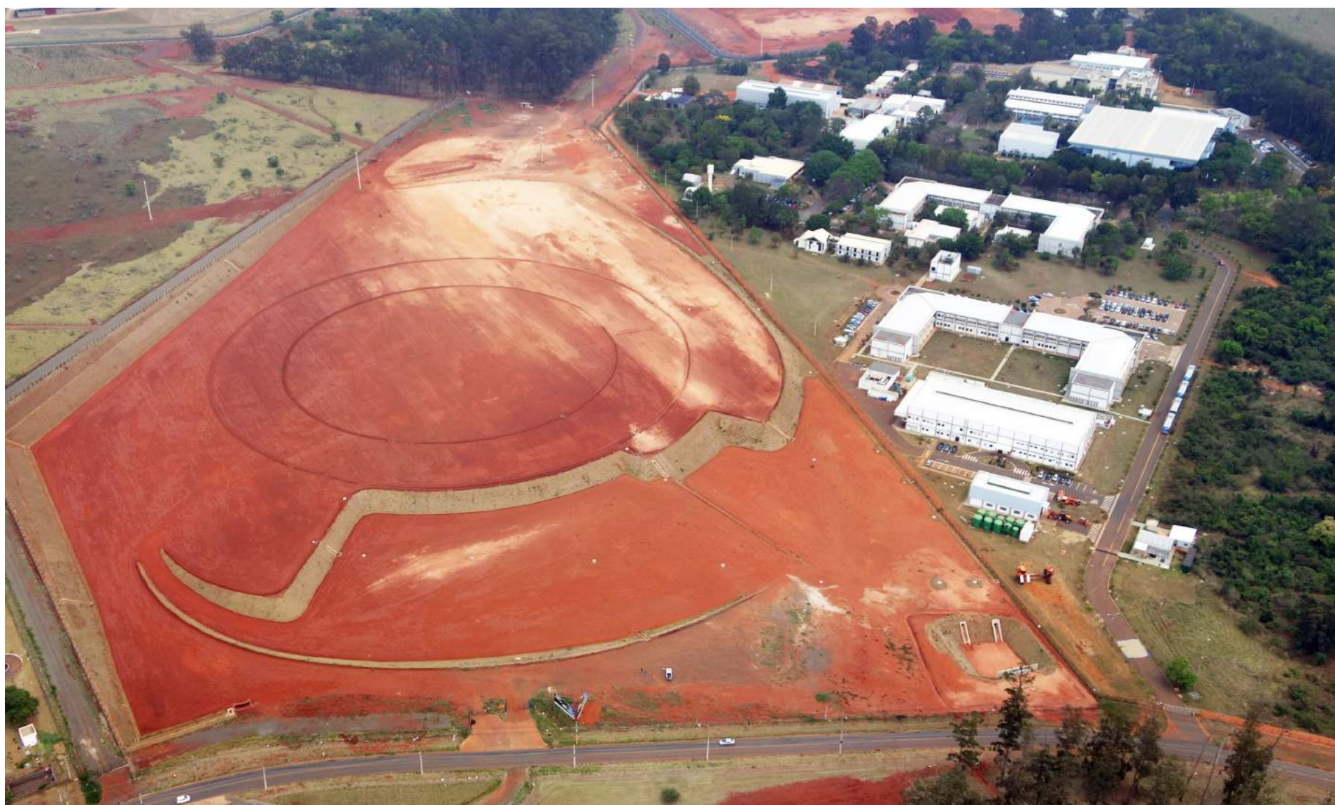
Área de implantação do edifício do Sirius após conclusão da terraplanagem do terreno
