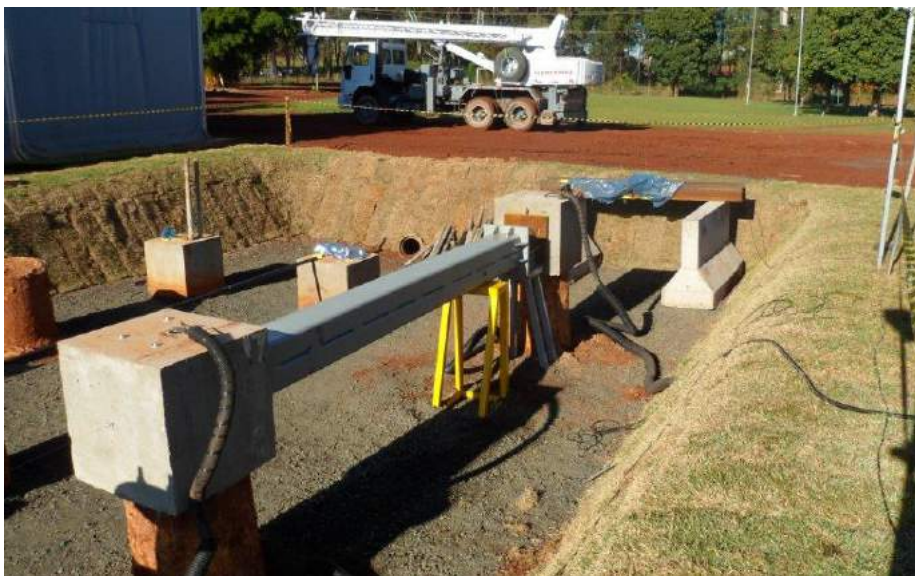
Estacas-testes para determinação de parâmetros da interação estaca-solo. Vista da montagem com instrumentação para testes de carga horizontal
