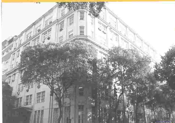
Fachada do prédio antigo do INT.
