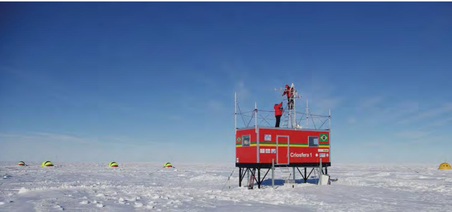
**Módulo científico Criosfera 1**, instalado no interior do manto de gelo antártico (84°00'S, 79°30'W) no verão de 2011/2012. Este módulo é totalmente automatizado e serve para o monitoramento da química atmosférica e análise meteorológica. Ao fundo, o acampamento dos pesquisadores que trabalham no módulo. Fotografia: UFRGS.
