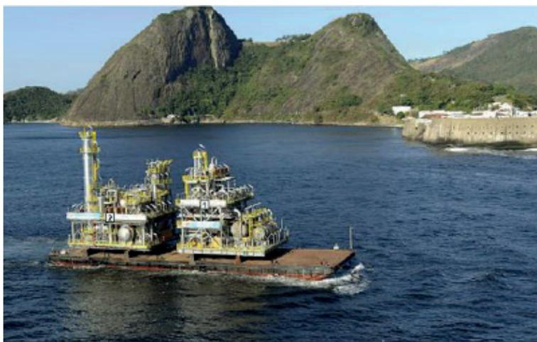
**Figura 25** - Exemplo de dois módulos da Plataforma P-58, construídos no canteiro da UTC em Niterói (RJ), sendo transportados por balsa para um estaleiro no Rio Grande do Sul (agosto/2012).
