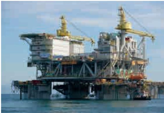
A plataforma SPAR é mantida na locação por meio de sistema de ancoragem do tipo *taut-leg*. Esse tipo de unidade possui amplitude de movimentos bastante reduzida, o que permite a utilização de poços de completação seca com *risers* tensionados, para diversos poços operarem em grandes lâminas-d'água com *risers* rígidos (*steel catenary unit*). As plataformas SPAR, até o momento, não são utilizadas no Brasil.
