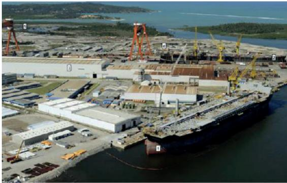
**Dimensões do dique seco:** L = 400 m de comprimento; D = 73 m de largura; e P = 12 m de profundidade.
