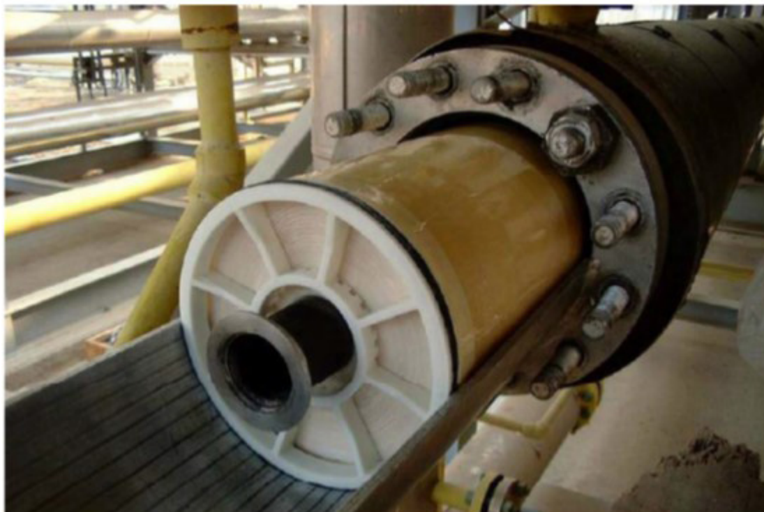
Figura 38 – Elemento Utilizado no Carregamento de Gás de um Módulo de Membrana
