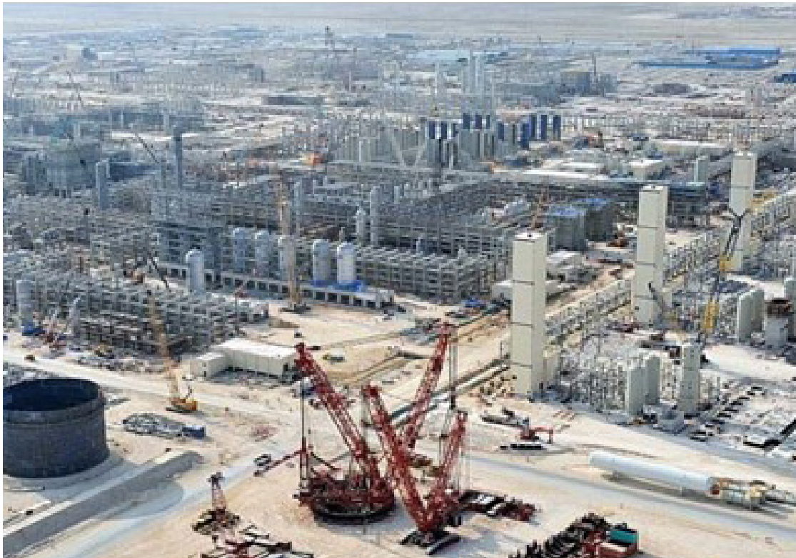
Figura 16 – Construção da ASU do Pearl GTL Project
