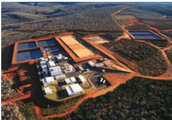
Figura 34 – Instalação da INB em Caetité
