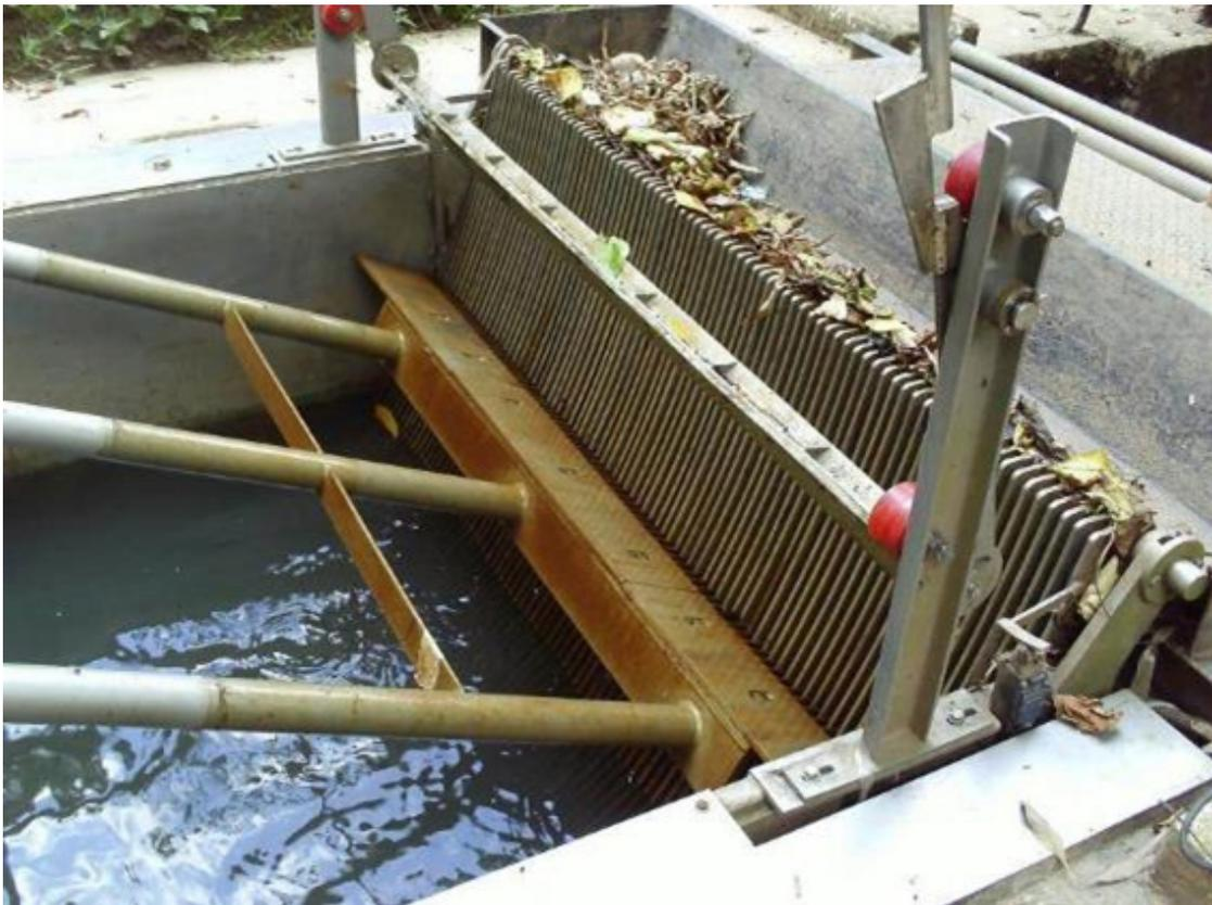
Figura 26 – Tratamento Preliminar de Esgotos – Gradeamento
