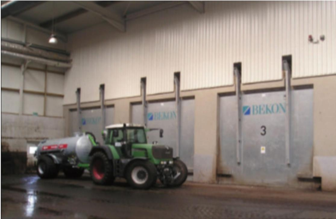
Figura 51 – Biodigestor de Garagem
