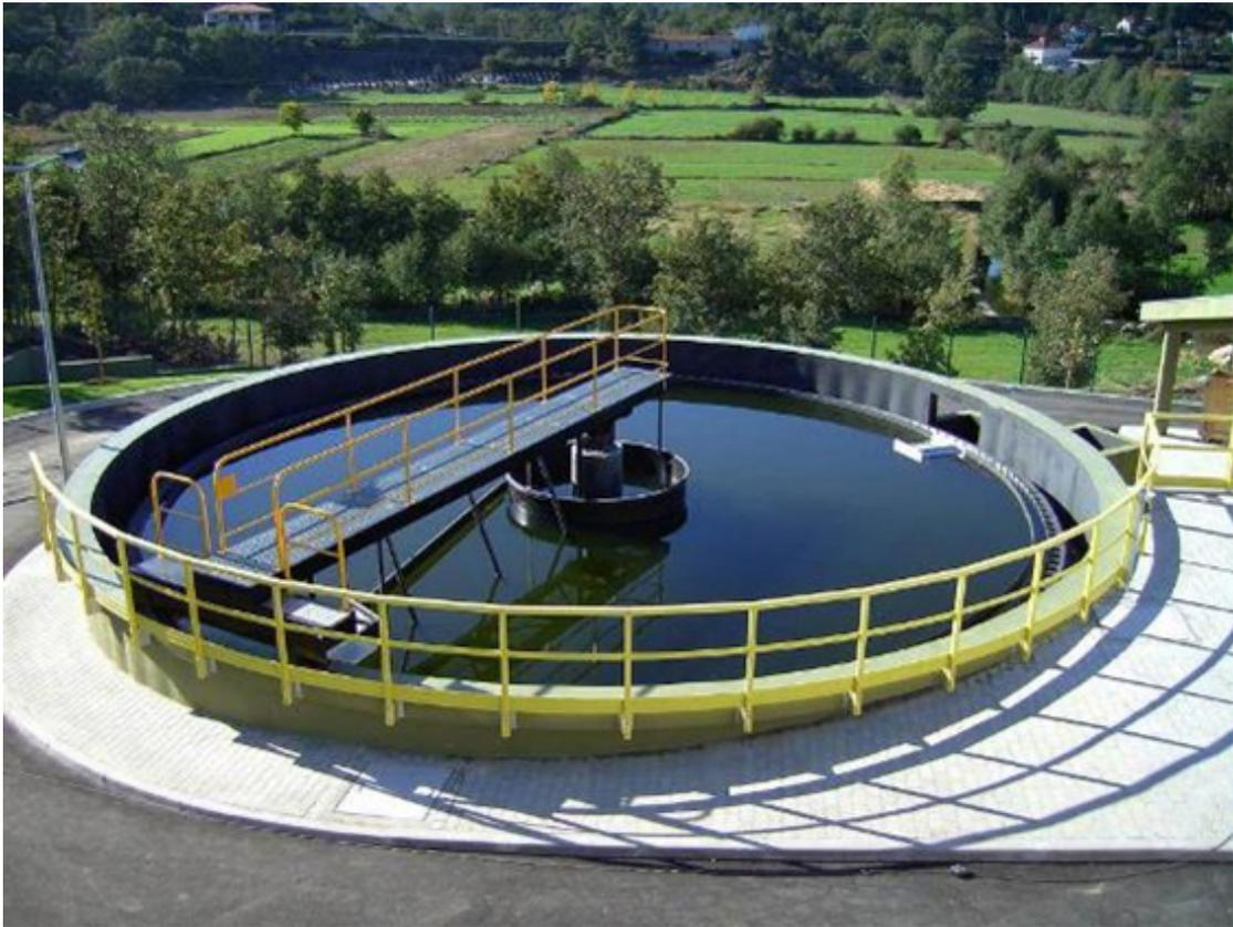
Figura 30 – Tratamento Primário de Esgotos – Decantador Primário
