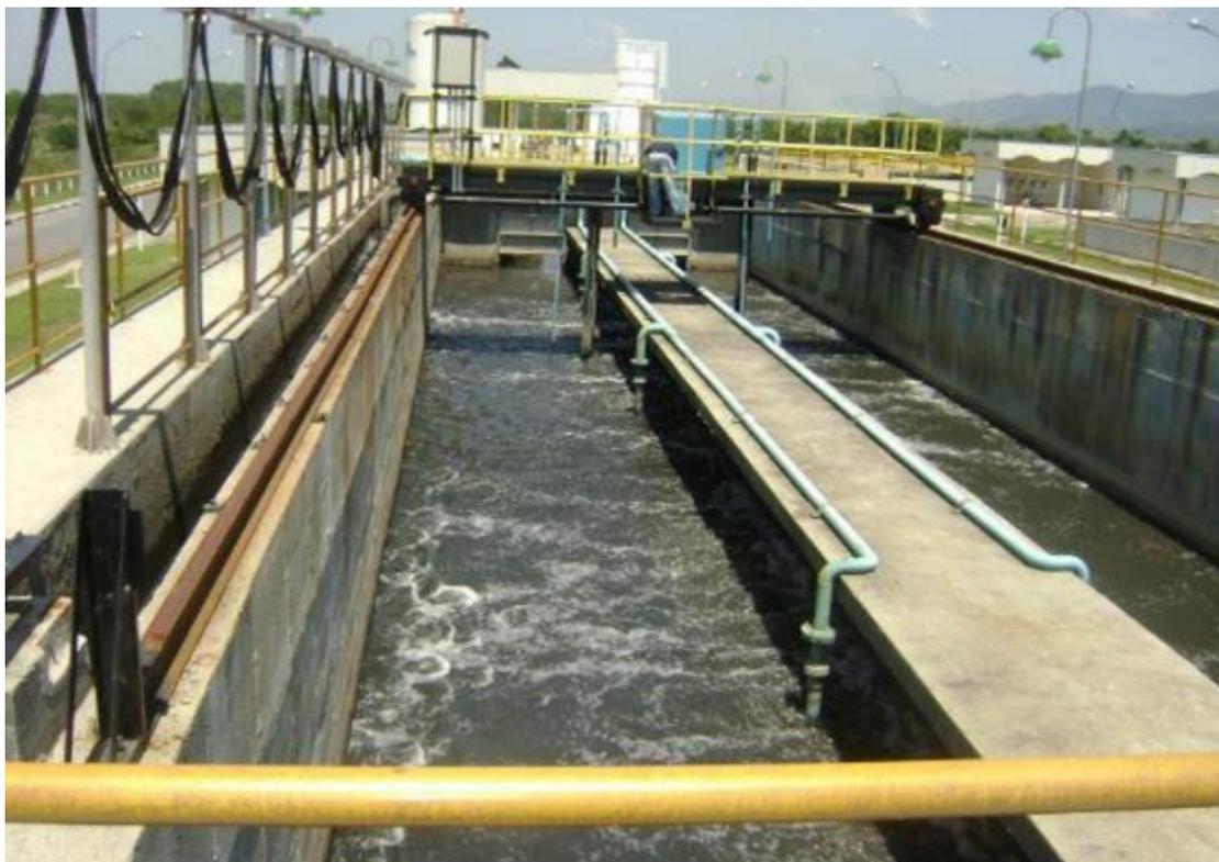
Figura 29 – Tratamento Preliminar de Esgotos – Caixa de Areia
