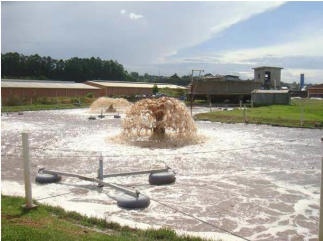
Figura 32 – Tratamento Secundário de Esgotos – Tanque Aerador
