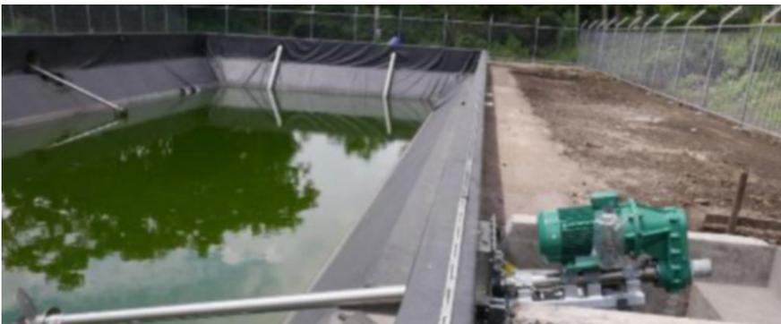
Figura 54 – Lagoa Anaeróbica com Misturador em Construção
