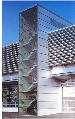
**FIGURA 10-** Placas fotovoltaicas inseridas na fachada (SCHIMITZ-GÜNTER, 1999)
