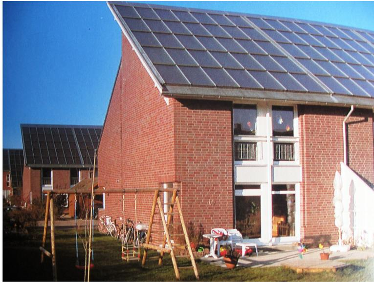
**FIGURA 15**– Placas para o sistema de aquecimento solar (SCHIMITZ-GÜNTER, 1999)
